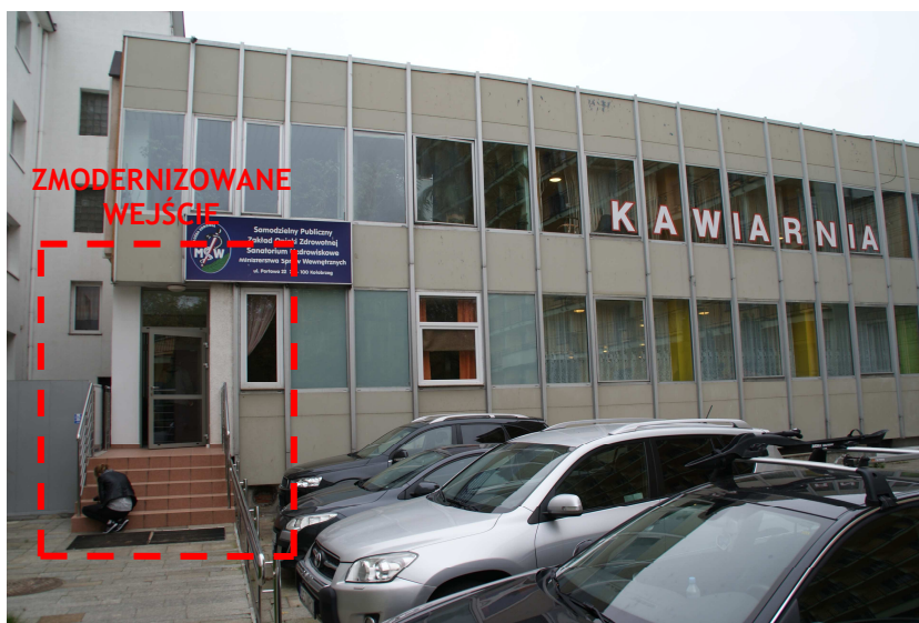
Widok na elewację północno-wschodnią /od str. ul. Spacerowej/.
