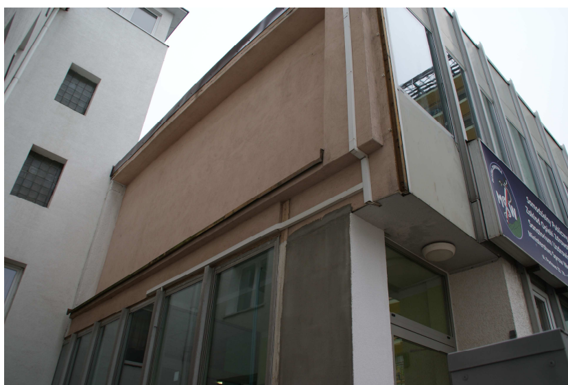
Widok na elewację południowo-wschodnią.
